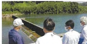
橋樑上流の可動堰の視察
