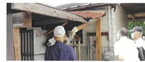
世代間交流施設の老朽化や破損の報告を受け視察
